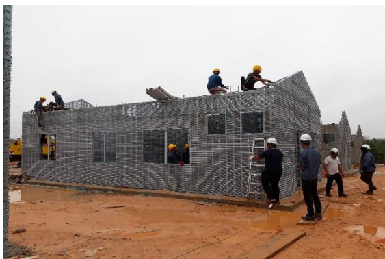
Rajah 1: Pembelajaran WBL di tapak bina bagi pemasangan kerangka keluli ringan
